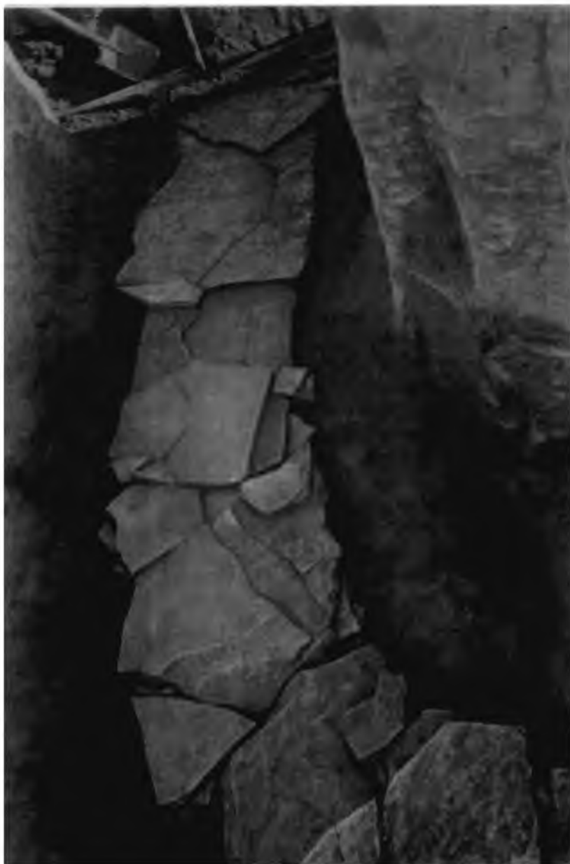
Рис. 31 Расчищенный жаровой подпольный канал, накрытый каменными плитками (1945 г.). По Л.А. Евтюховой
